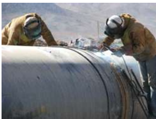
شکل ۱- شماتیکی از یک پروژه جوشکاری GMAW.
