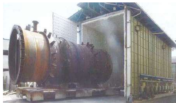
شکل ۲- عملیات حرارتی تنش زدایی مخزن ساخته شده در داخل کوره
