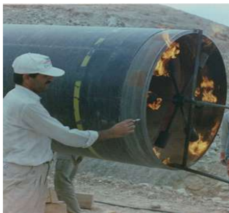
شکل ۱- پیش گرمایش سرلوله ها قبل از جوشکاری از داخل لوله و کنترل دمای پیش گرمایش از بیرون لوله (برای خط لوله)
