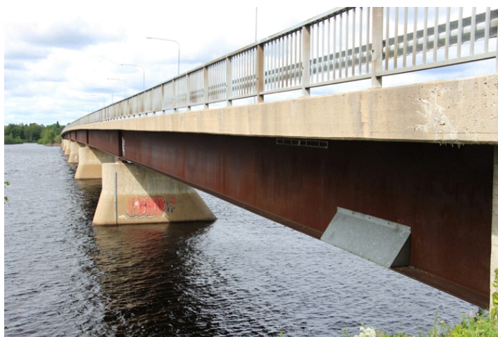
شکل 5 - طولی ترین پل کشور فنلاند در Tervola در سال 1975 میلادی از فولاد مقاوم به خوردگی جوی ساخته شده است.
